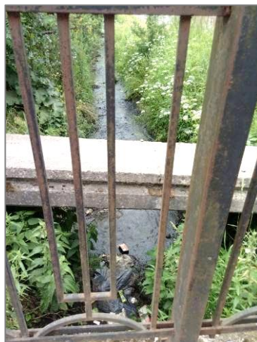
Мусор в канаве около ж/д-станции
