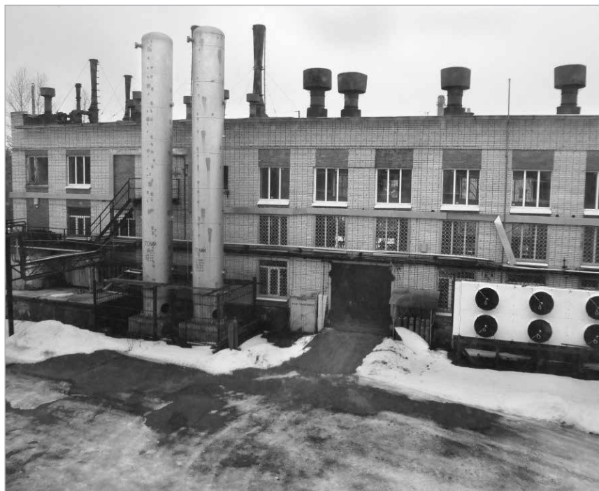
Криогенная пристройка к первому корпусу
