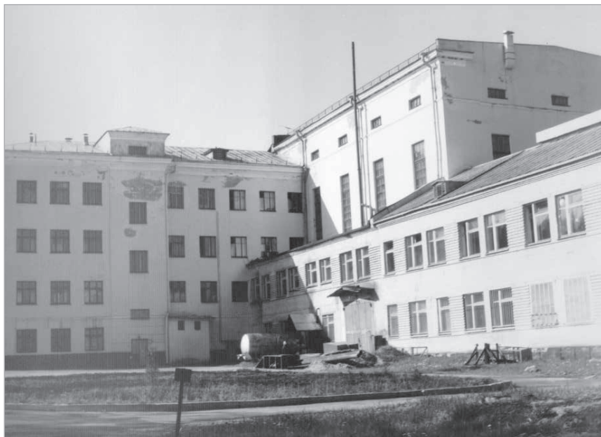
Вид здания реактора ВВР-М с северо-восточной стороны
