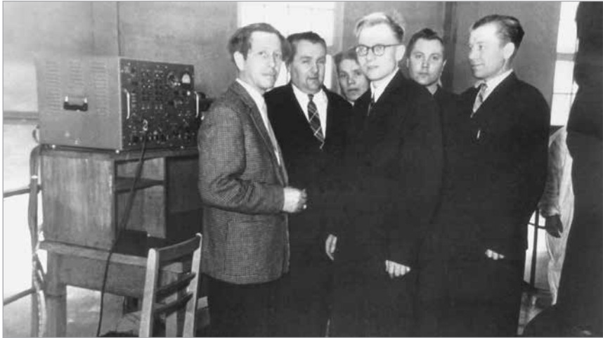
Монтажники на пуске. Слева направо: И. А. Иоффе, Л. Я. Луммер, слесарь-монтажник Васильев, К. А. Коноплев и др.
